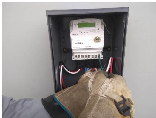
Figura 3 – Retirada do condutor de saída
