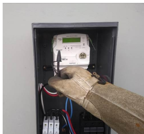
Figura 2 – Isolamento do condutor
