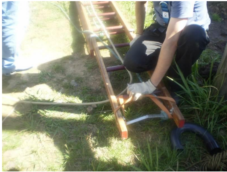
Figura 13 – Instalação da linha de vida
