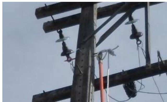
Figura 31 – Instalação do agulhão no poste
