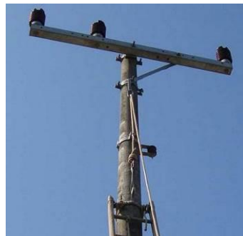
Figura 17 – Ancoragem na ferragem do poste
