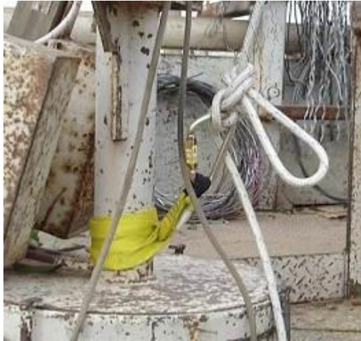
Figura 11 – Ponto de ancoragem
