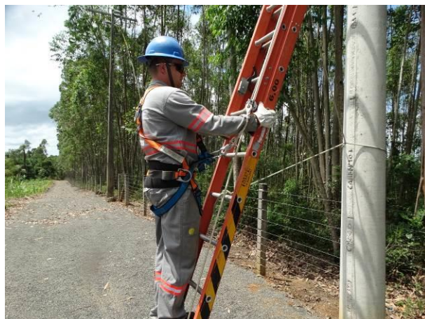
Figura 37 – Subida na escada
