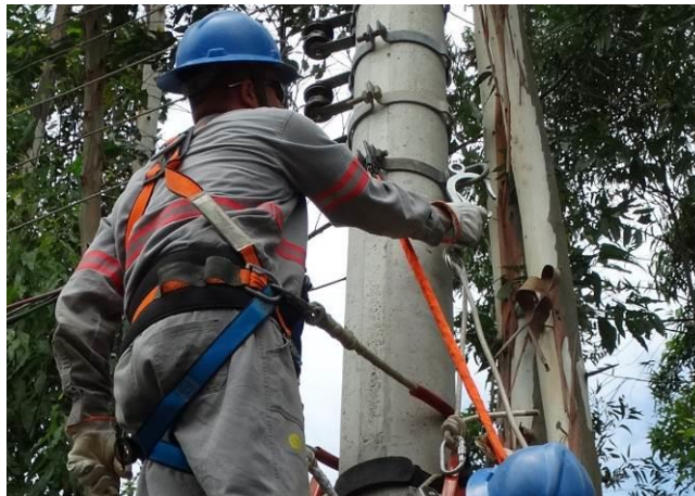
Figura 48 – Fixação do ponto de ancoragem
