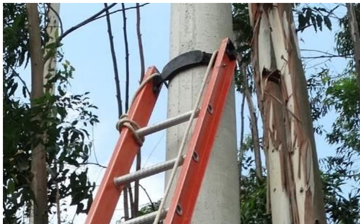
Figura 22 – Posicionamento da escada
