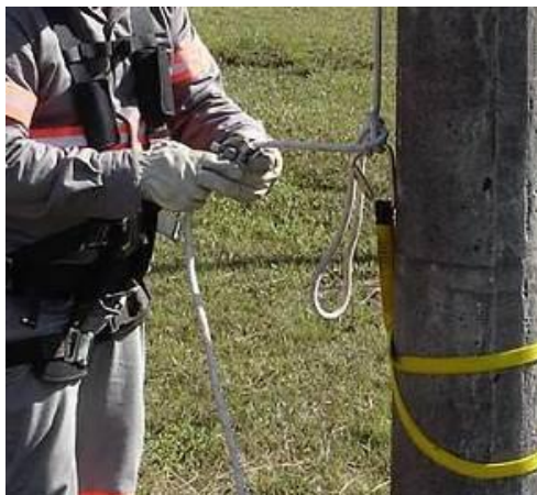
Figura 39 – Instalação do trava-quedas
